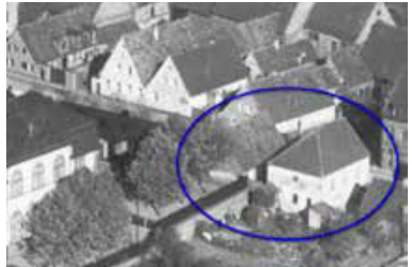
Abb. 2 Ausschnitt aus einem Luftbild (etwa 1930) (Blau eingekreist: Synagoge (rechts) und jüdisches Schulhaus)
