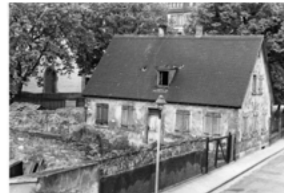
Abb. 9 Blick auf die zerstörte Synagoge und das unzerstörte jüdische Schulhaus
