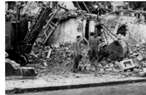
Abb. 10 Abbruch des ehemaligen jüdischen Schulhauses (1962). Vorne rechts der Grundstein des Gebäudes von 1841. In der Mitte mit Baskenmütze Franz Gember.
