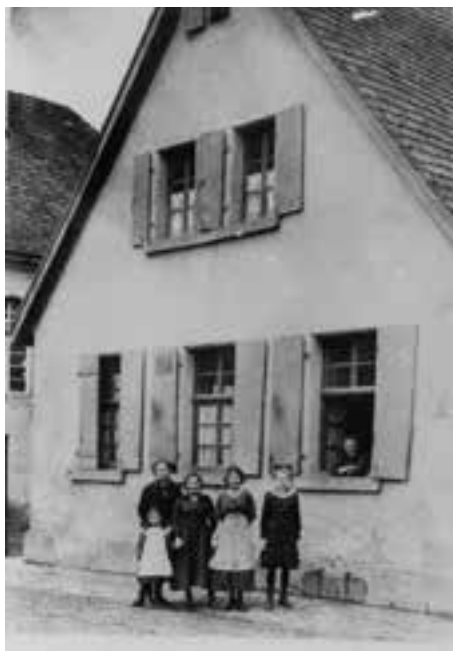
Abb. 5 Blick auf das jüdische Schulhaus; im Hintergrund links die Synagoge
